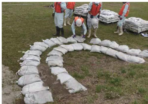
水漏れ防止のため、1段毎に土のうの継ぎ目、合わせ目、内側土のうと外側土のうの間に良質の土を詰め、締め固める。
