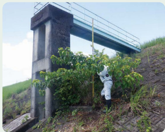
▲高知河川管理施設監理検討業務 樋門取付護岸樹木侵入状況
