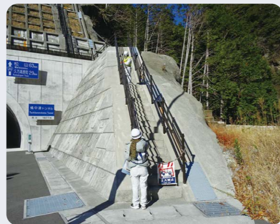
▲土佐管内道路管理データ整備登録業務 現地調査
