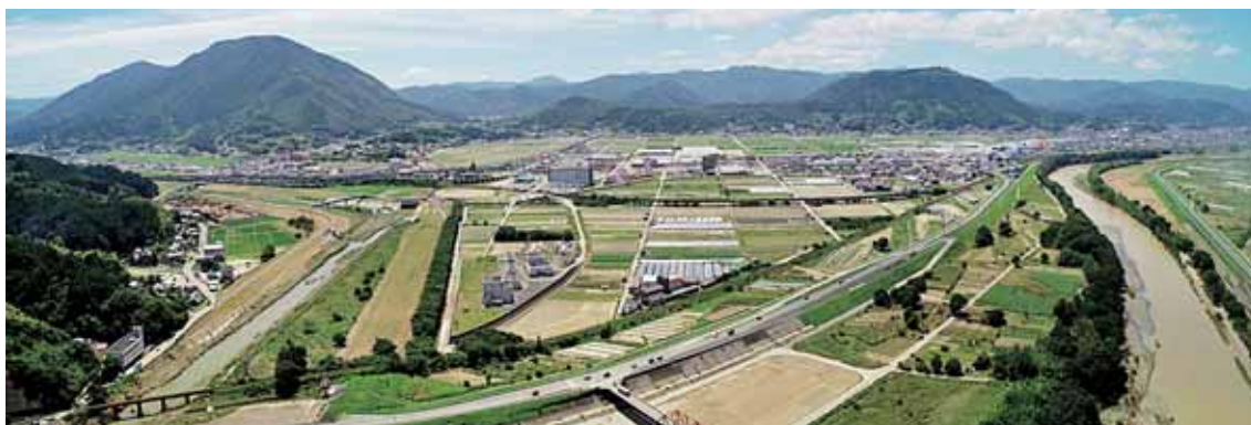
越流が発生した暫定堤防付近から浸水した東大洲を望む (撮影高度：100m、パノラマ撮影)
