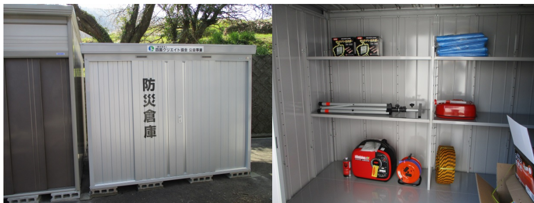
防災倉庫設置状況
